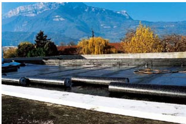
L'isolation d'une toiture-terrasse
